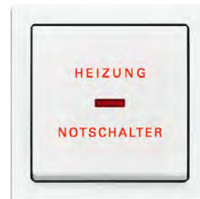
Abb. 7-2: Gefahrenschalter (Not-Aus)
